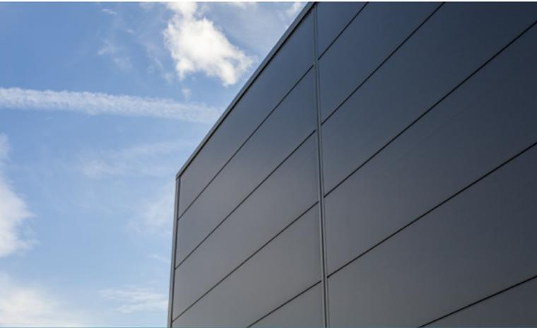
Panel de fachada con doble revestimiento metálico en espuma de poliuretano o poliisocianurato. Su característica principal está en la fijación y tornillería pasante oculta.
